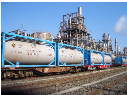
*当社主力製品の鉄道タンクコンテナと荷役充填設備
